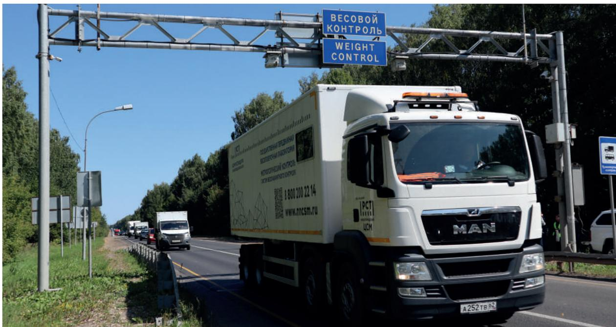
Фото 1. Автоматический пункт весового и габаритного контроля (АПВГК)
